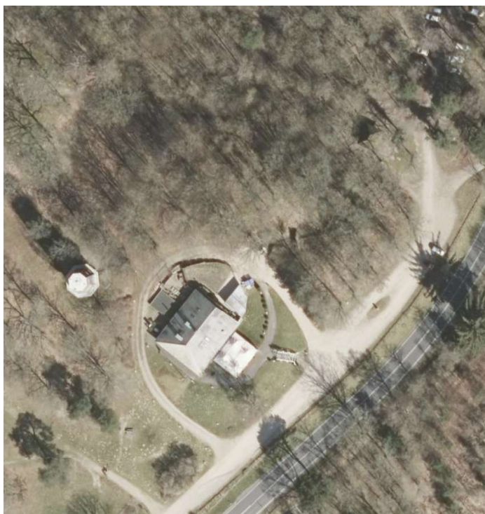
Figur 20: Luftfoto af restauranten med udsigtstårnet. Foto: Geo Fyn A/S
